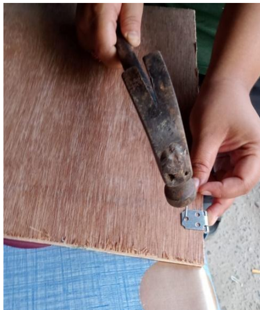
Gambar 4.9 menyatukan triplek menggunakan engsel
