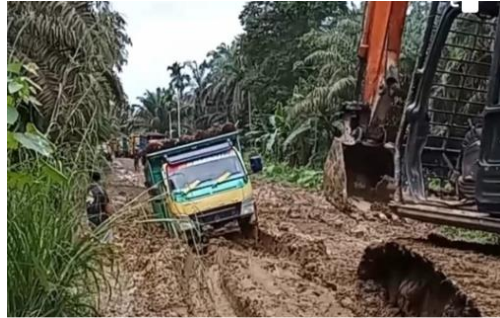
Gambar 1.10 Kondisi jalan rusak aktivitas operasional perusahaan
