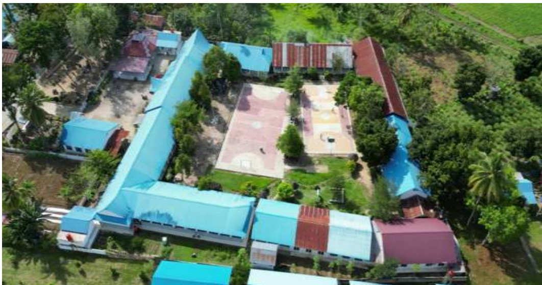
Gambar 1.2 denah SMA N 3 Panyabungan diambil dari atas menggunakan dron dan dekat dengan perguruan tinggi STAIN MADINA.
