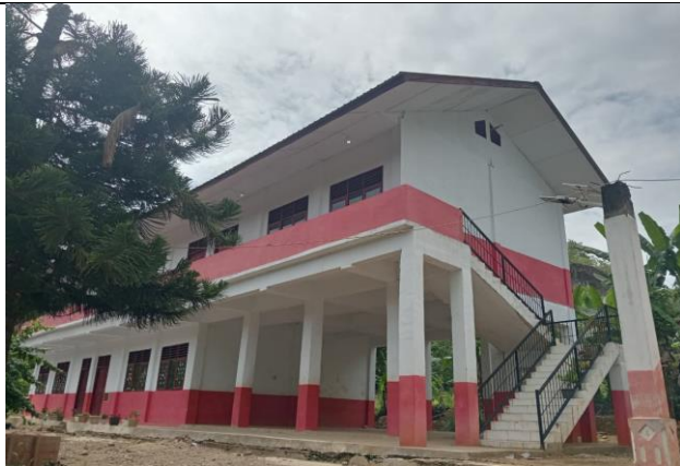
Foto bangunan sekolah setelah direnovasi (2025)
