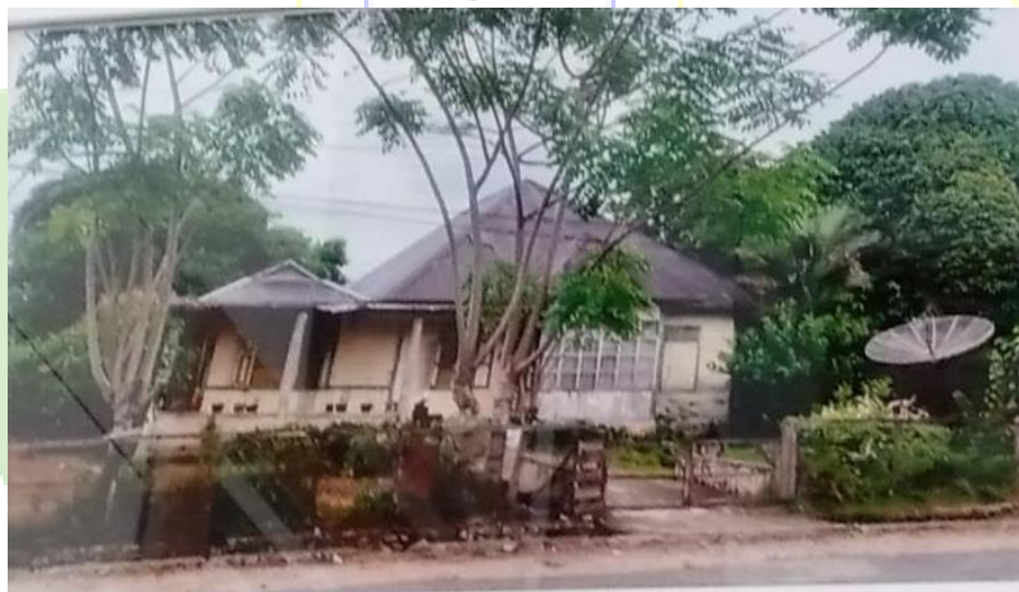
Gambar 2: Museum Ulama Hutasantar Sebelum di Renovasi
